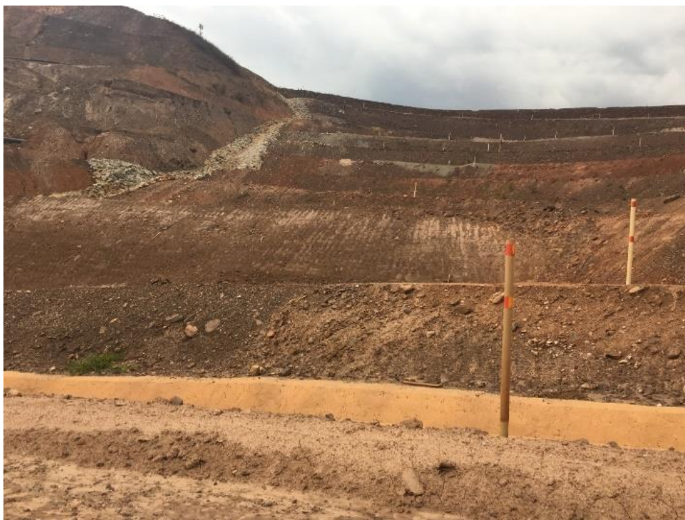
Figura 5.14 - Dique de Selinha.
