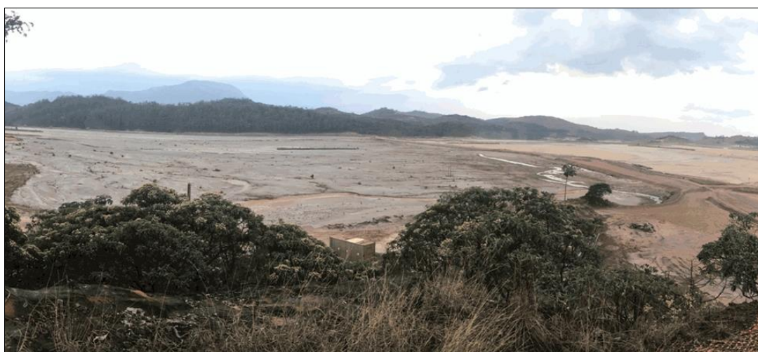
Figura 5.20 - Barragem e reservatório Baia 3 no setor E.
