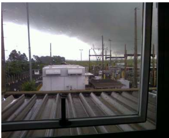
Figura 2.10 – Vista da janela em Uruguaiana aonde foram filmados alguns raios da campanha 2006/2007.
