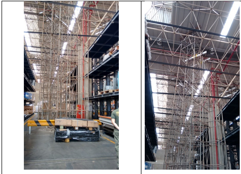
Figura 21 - Estrutura apoiada em reforços
