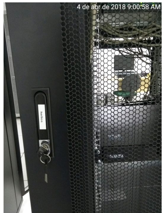
Fig. 05 – No helios, placa de patrimônio, nós computacionais, unidade de armazenamento e a porta da unidade.
