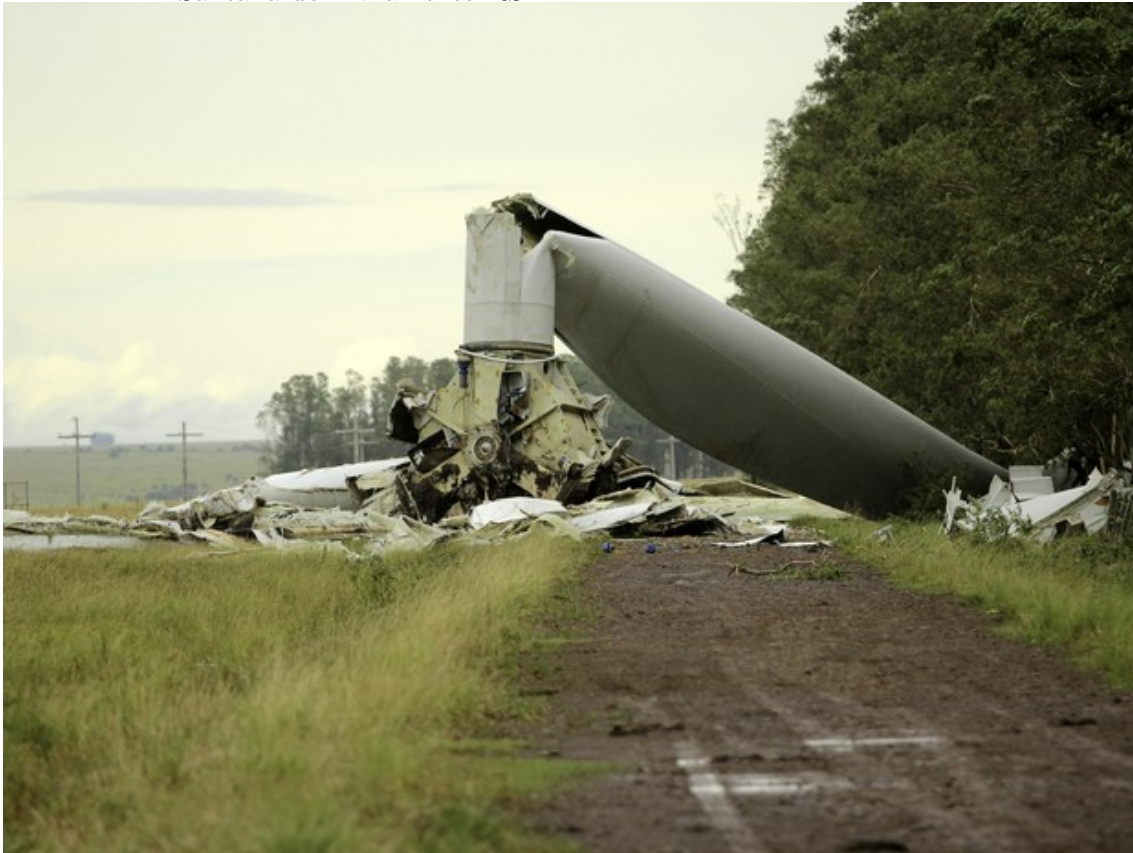
Figura 5.51 - Torre de energia eólica derrubada pelo vento na tarde do dia 20/12/2014 em Santana do Livramento-RS.
