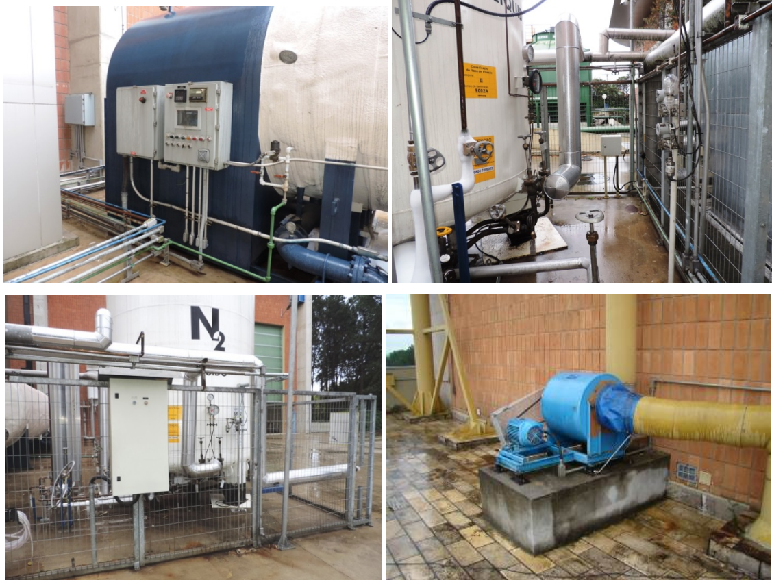
FOTO 01 - Vista geral das instalações externas a serem protegidas por coberturas.
