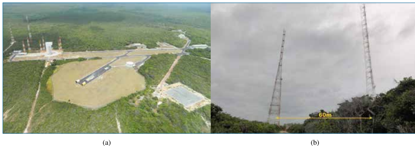
Figura 1: CLA: (a) local de lançamento com as torres anemométricas de fundo e (b) disposição das torres.
