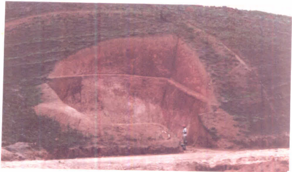
Fig. 8 - Corte no morro para construção do paio.
