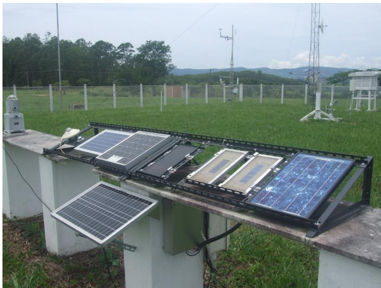
Figura 3.1 - Instalação dos módulos fotovoltaicos no LIM/INPE.
