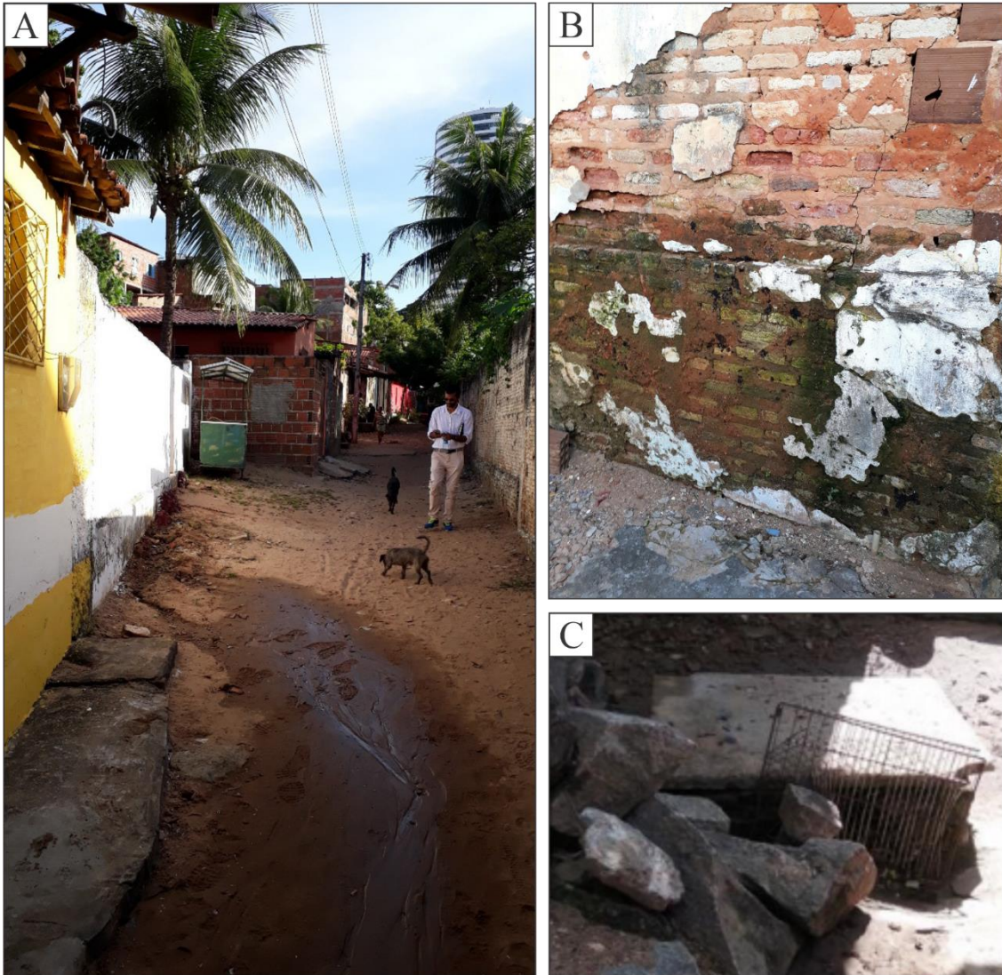
Figura 5.5: Fatores deflagradores e evidências de alagamentos, em (A) observa-se a ausência de um sistema de drenagem eficaz, em que a água servida é liberada diretamente nas porções inferiores da encosta, em (B) a marca que expressa a altura que a coluna d'água atingiu em um momento de precipitação intensa, e em (C) bueiro clandestino com tela improvisada para evitar entupimento do canal (Fonte: França, 2018).
