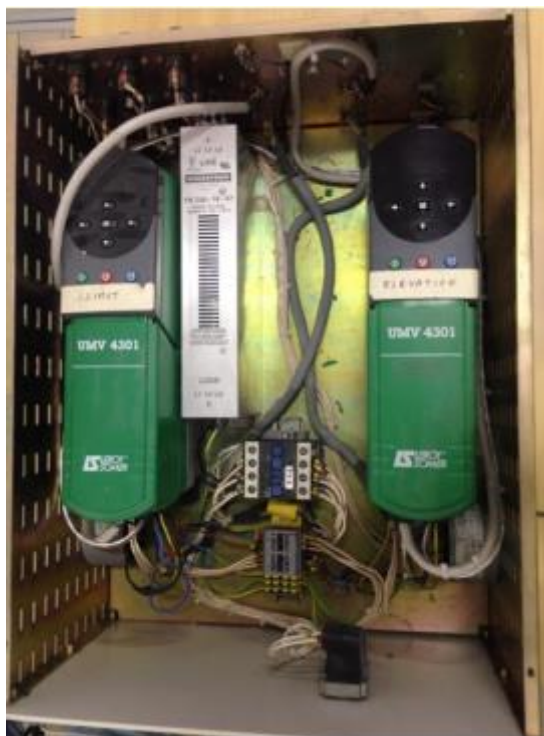
Figura 9 - Gaveta de potência. Fonte [2].
