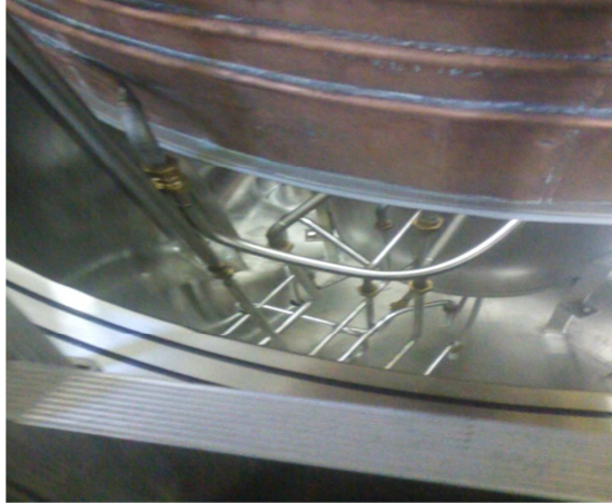
Figura 3.3.3-Tubulações da câmara criogênica a vácuo
