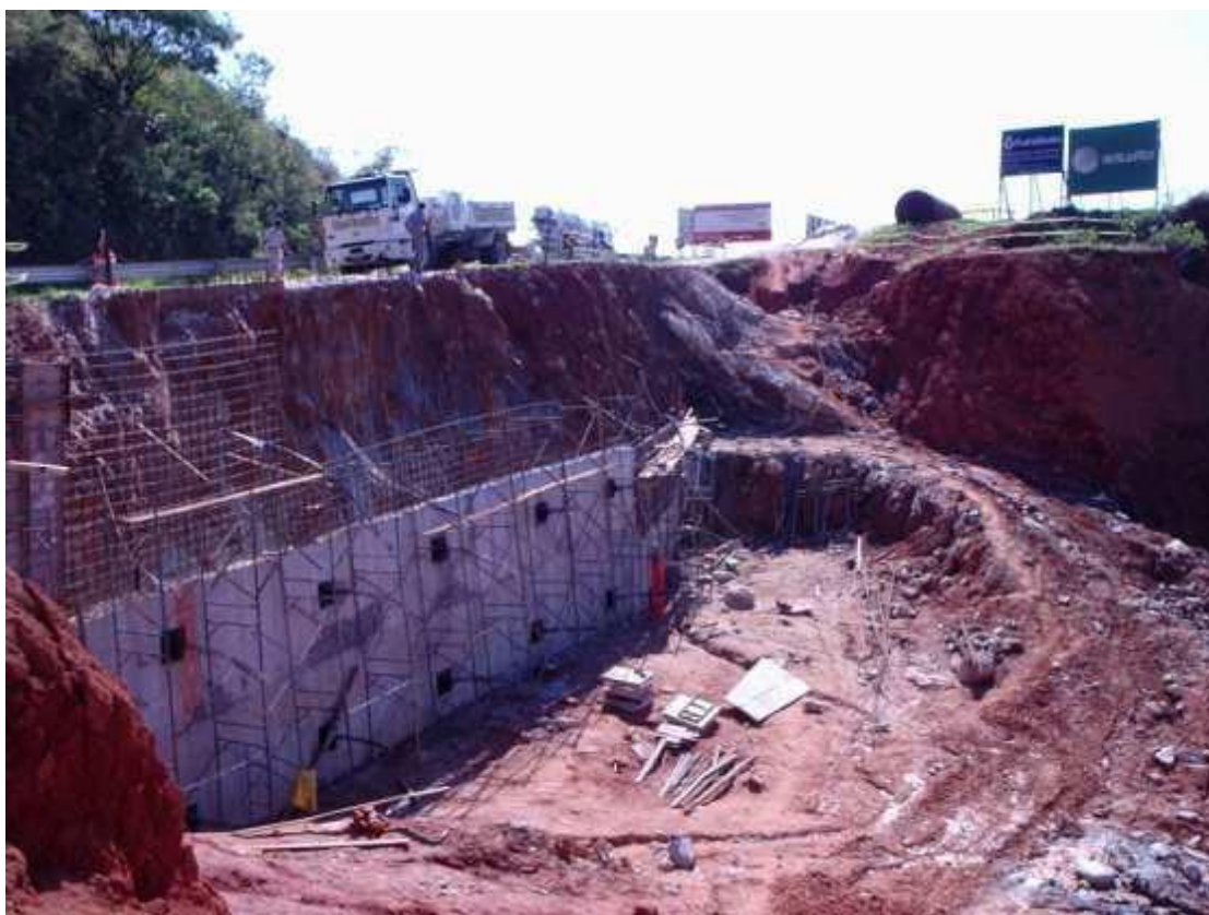
Figura 3.4. Local de coleta das amostras de solo, situado na rodovia Floriano Rodrigues Pinheiro (SP-123), km 30, no município de Santo Antônio do Pinhal, SP. Fonte: [1].
