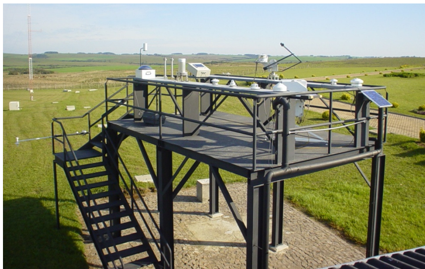
Figura 2.2. Estação solarimétrica e anemométrica SONDA – SMS instalada no Observatório Espacial do Sul – OES/CRS/CCR/INPE – MCT, em São Martinho da Serra, RS.
