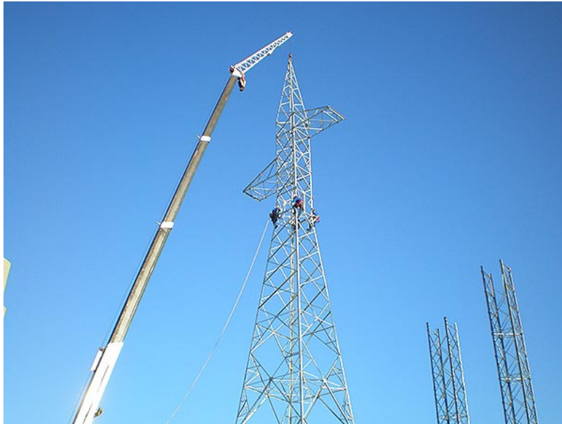
Figura 32 - Modelo de torre autoportante treliçada.
