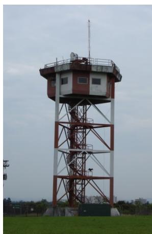
Figura 2.10. Torre de observação.
