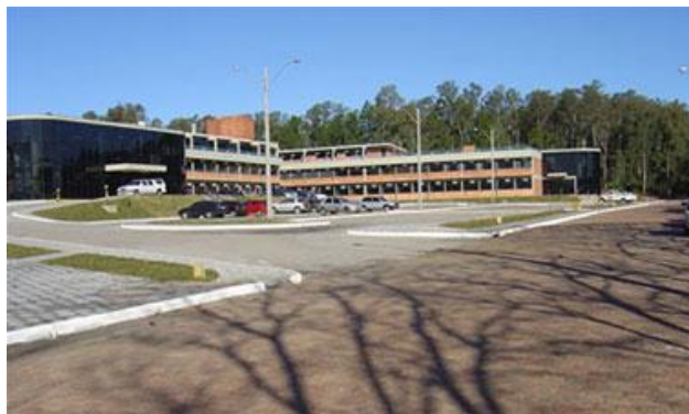
Figura 5 - Prédio Sede do Centro Regional Sul de Pesquisas Espaciais. 5
