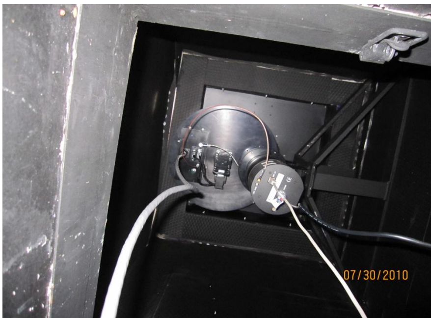
Figura 4.3 – Equipamento instalado no Observatório Espacial do Sul – OES/CRS/INPE - MCT –, em São Martinho da Serra, RS - Imagem interna do equipamento.
