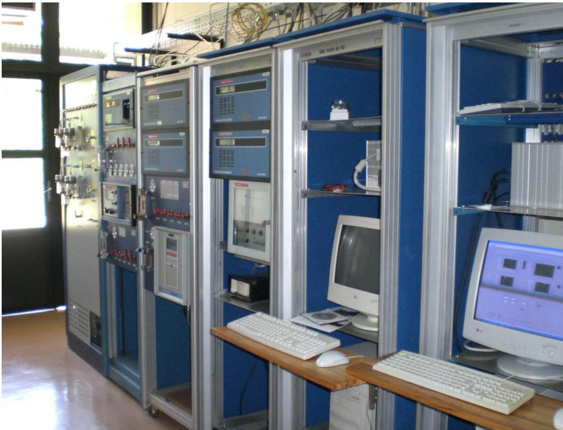
Figura 4 – Vista Geral dos Analisadores dos Gases  $\text{CO}_2$ ,  $\text{CO}$ ,  $\text{NO}_x$  e UHC.
