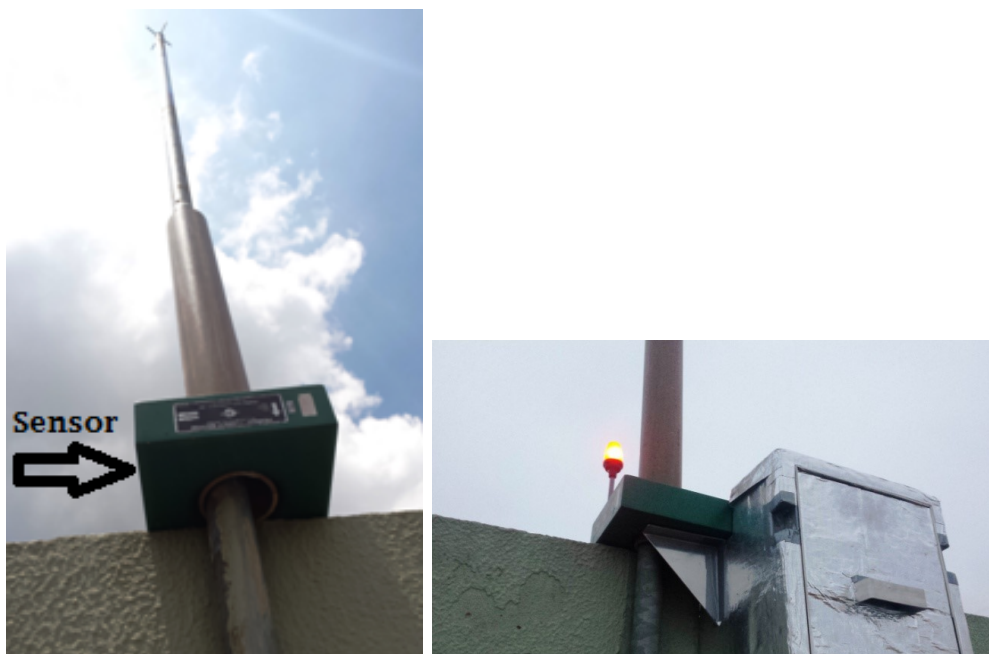
Figura 3.7 - Sensor de corrente no para-raios.
