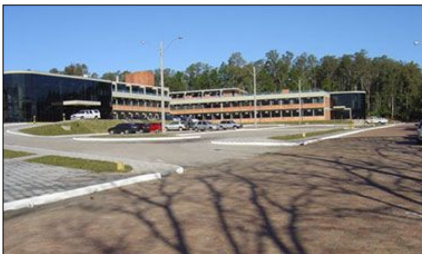
Figura 2 – Prédio do Centro Regional Sul de Pesquisas Espaciais – CRS/INPE – MCT 2 .
