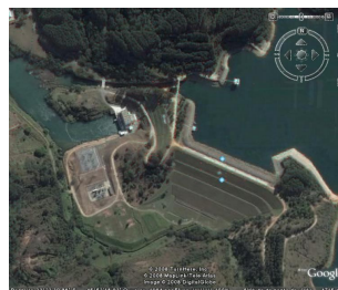
Reservatório de Água Santa Branca - SP
