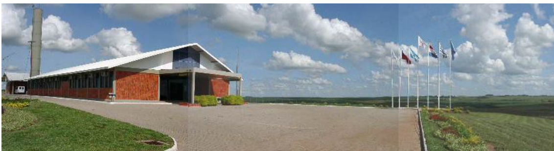
FIGURA 32: Foto do prédio principal OES, onde está instalado o TCM, em São Martinho da Serra.
