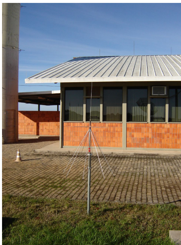
FIG. 5.2 - ANTENA MONOPOLO UTILIZADA NO PROJETO E INSTALADA AO LADO DO PRÉDIO 6 NO OBSERVATÓRIO ESPACIAL DO SUL, EM SÃO MARTINHO DA SERRA, RS.
