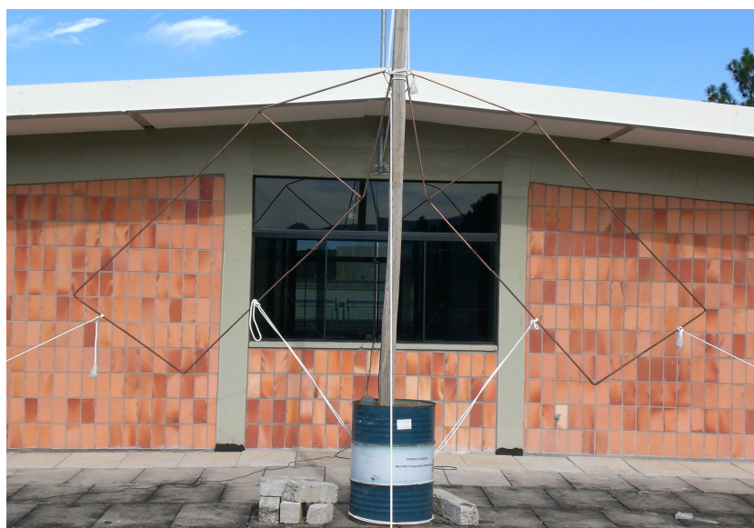
FIG. 5.3 – PRIMEIRO PROTÓTIPO DE ANTENA DIPOLO SIMILAR À USADA NO SISTEMA LOFAR, DESENVOLVIDA E MONTADA PARA TESTES NA COBERTURA DO PRÉDIO SEDE DO CENTRO REGIONAL SUL DE PESQUISAS ESPACIAIS – CRS/CIE/INPE – MCT, EM SANTA MARIA, RS.
