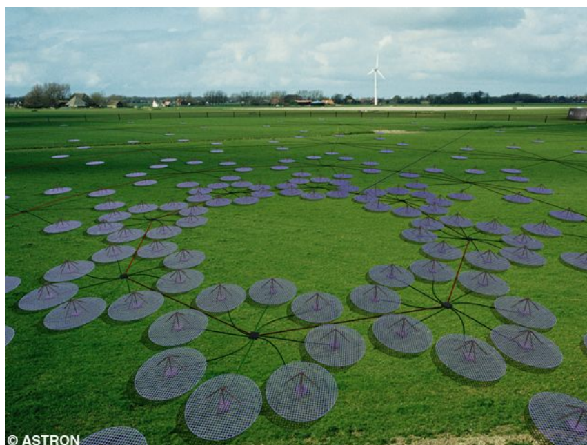
FIG. 1.3.1 – REPRESENTAÇÃO DE UMA ESTAÇÃO LOFAR
