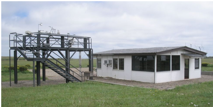
Fig. 4.1 – Plataforma com equipamentos instalados e prédio 1 no Observatório Espacial do Sul, em São Martinho da Serra, RS.
