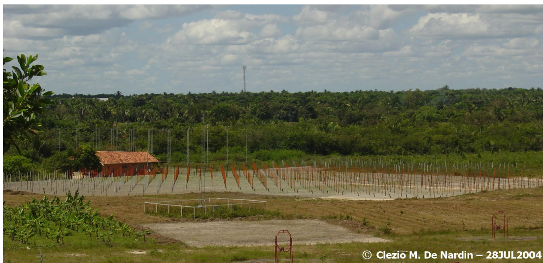
Fig. 4.1 – Fotografia do Observatório Espacial de São Luís do Maranhão do INPE/MCT, onde podem ser visto o conjunto de antenas do Radar de Espalhamento Coerente - RESCO. FONTE: Cortesia Dr. Clezio Marcos De Nardin.
