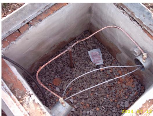
**Figura A.4** – Caixas de controle, tanto do aterramento com para a passagem de cabos no Observatório Espacial do Sul do CRSPE/INPE – MCT, em São Martinho da Serra, RS.
