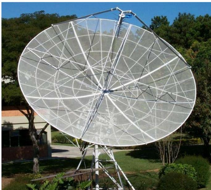
Figura 3 – Visão da antena de 9 metros de diâmetro do BSS.
