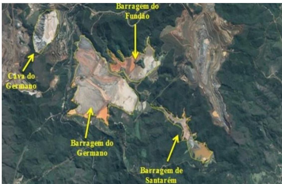
Figura 2.2 – Barragens de responsabilidade da empresa Samarco Mineração S/A.
