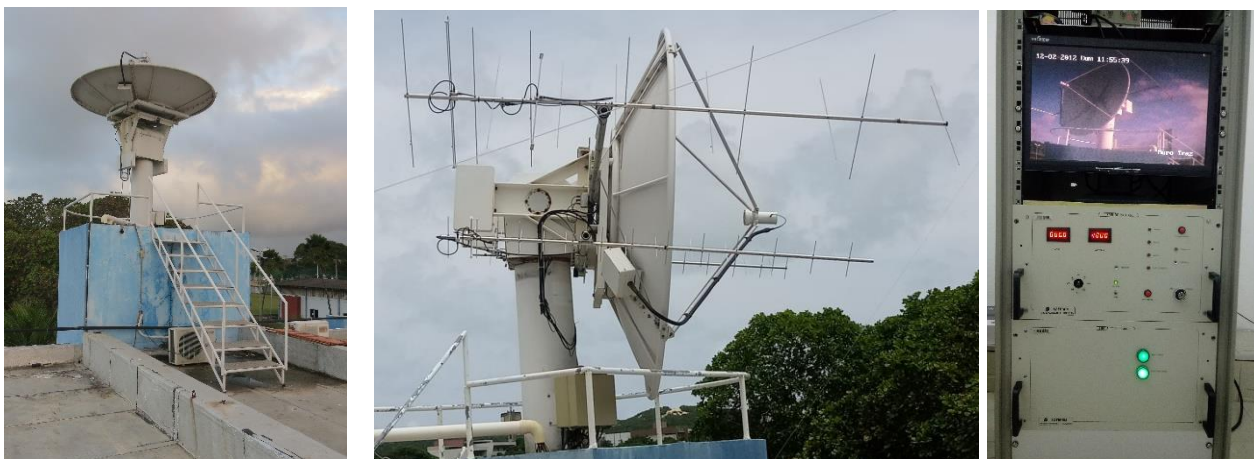
Figura 3. Instalações da Estação Multi-Missão de Natal
