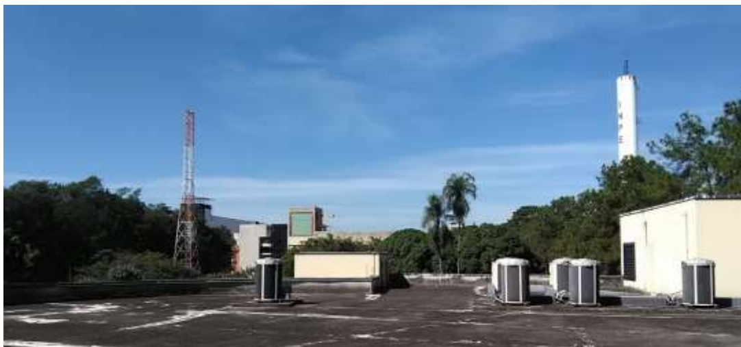
Figura 2.1 – Torres, instrumentadas, localizadas nas imediações da sede do INPE.
