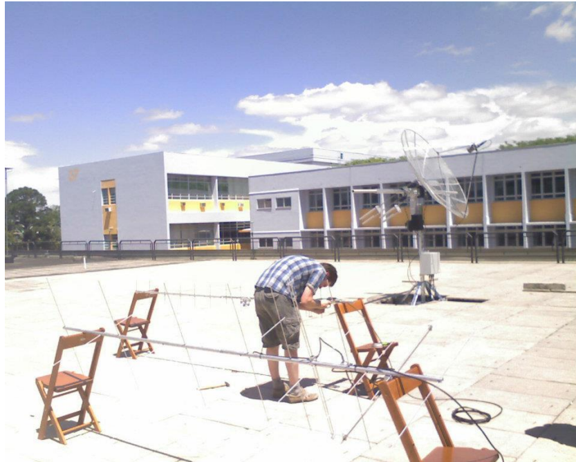
Figura 9 – Montagem das antenas UHF e VHF
