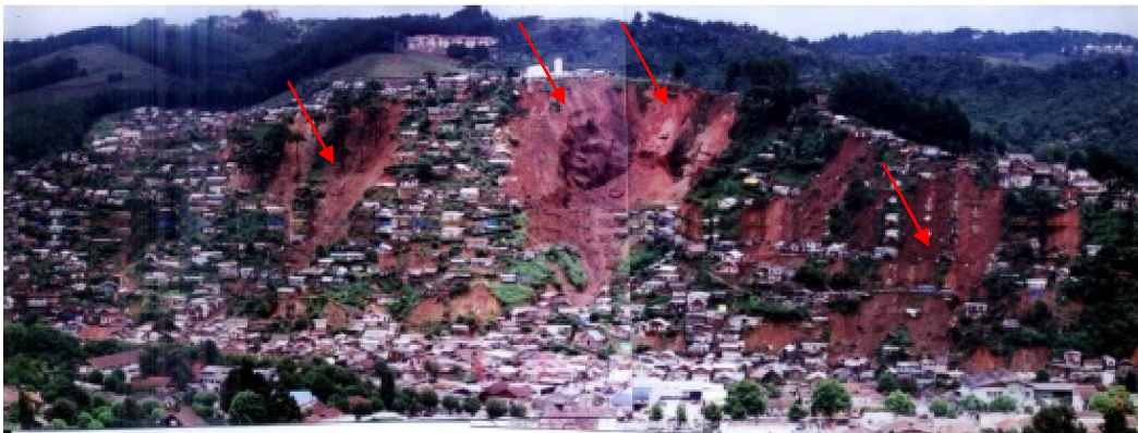
Figura 2.6. Deslizamento no bairro Britador no ano 2000.
