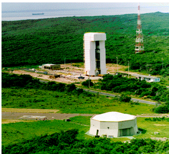
Figura C.2 - Vista da Casamata e do Lançador Universal de porte médio.
