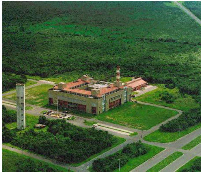
Figura C.3 - Vista do Centro Técnico (CT).
