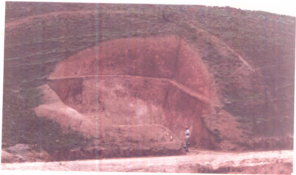
Fig. 8 - Corte no morro para construção do paio.
