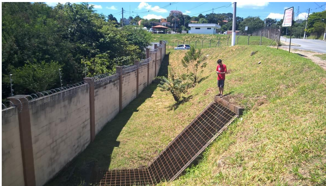
Figura 28 – Passagem do Córrego Seco canalizado sob a Avenida do Cristal
