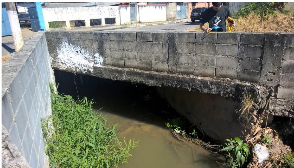
Figura 16 – Passagem sob a Rua Santa Cecília
