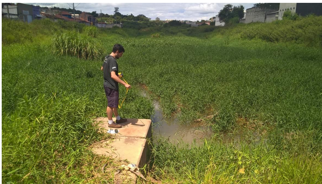
Figura 21 – Piscinão entre as Ruas Dom Manoel e Marquês de Olinda
