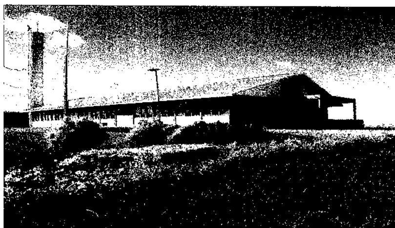
Fig. 7.1 – Prédio 2 do Observatório Espacial do Sul - OES/CRSPE/INPE – MCT, em São Martinho da Serra, RS onde se encontra as estações GPS instaladas, no âmbito da Parceria INPE – Cornell University.
