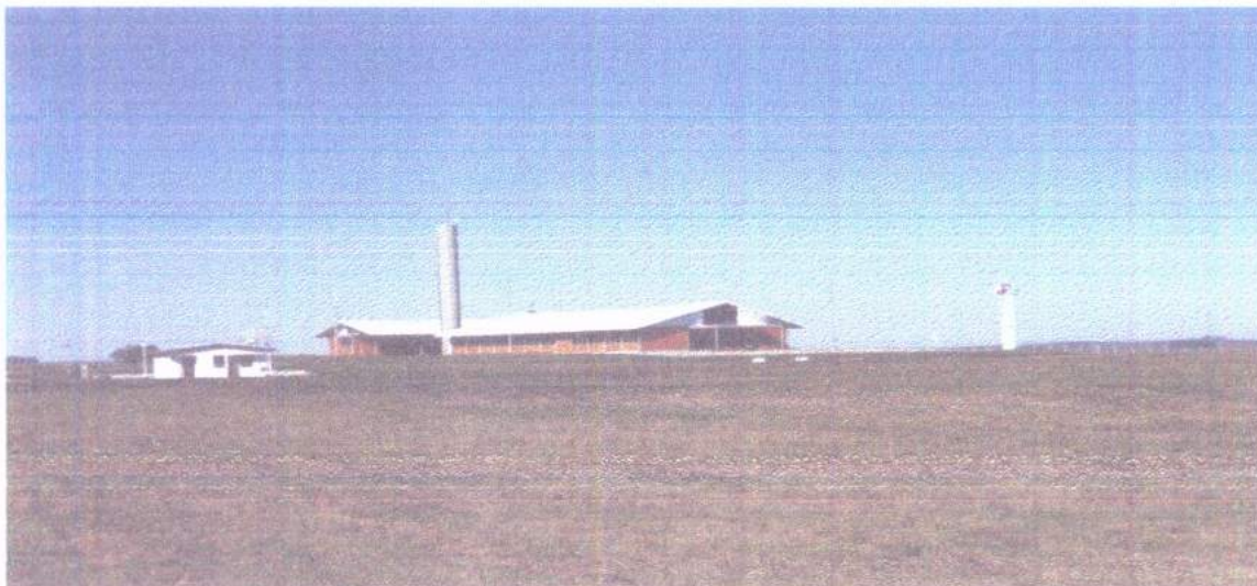
Figura 1 - Prédios 1, 2 e 3, de um total de seis prédios, do Observatório Espacial do Sul - OES/CRSPE/INPE, em São Martinho da Serra - RS.
