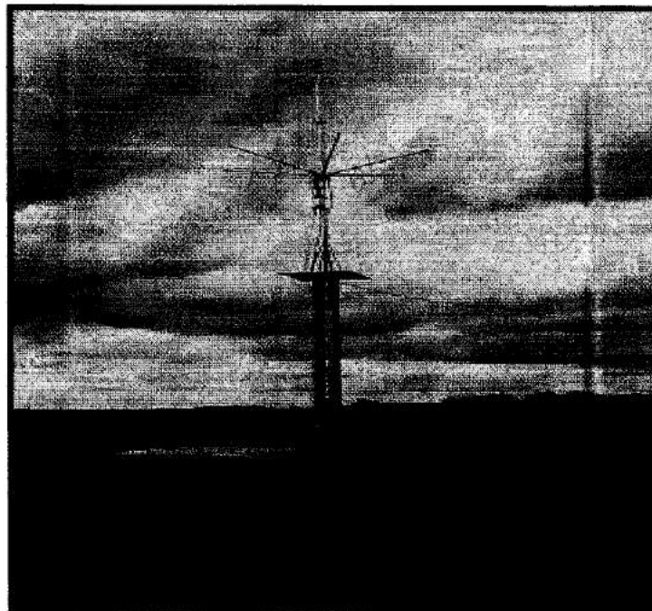
Figura 13 - Antena de recepção dos dados do sistema W-9000
