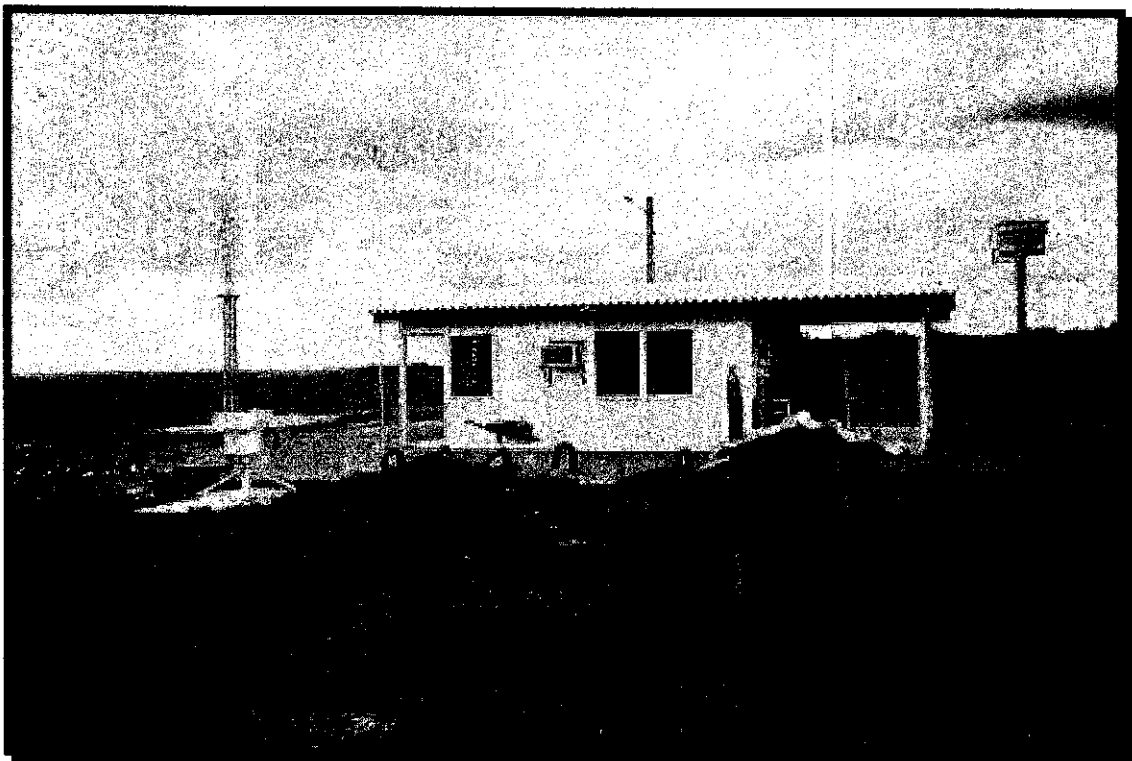
Figura 2 - Prédio 1 do Observatório Espacial do Sul CRSPE - INPE
