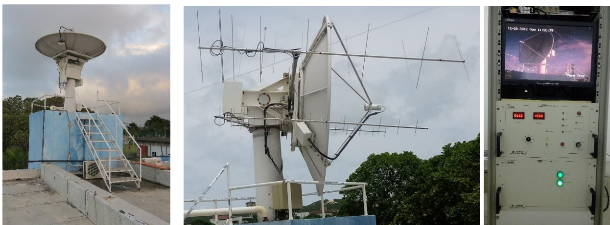
Figura 3. Instalações da Estação Multi-Missão de Natal
