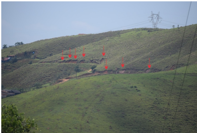
Figura 4.10 – Deslizamentos de terra induzidos por taludes de cortes em estradas na bacia do Bengalar. Setas vermelhas indicam as cicatrizes de deslizamentos de taludes.
