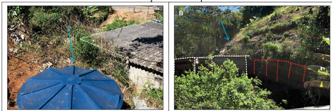
Figura 5.13 – Imagens da Encosta 55 com destaque para a caixa d'água em topo de talude de corte e edificação de baixo padrão construtivo.
