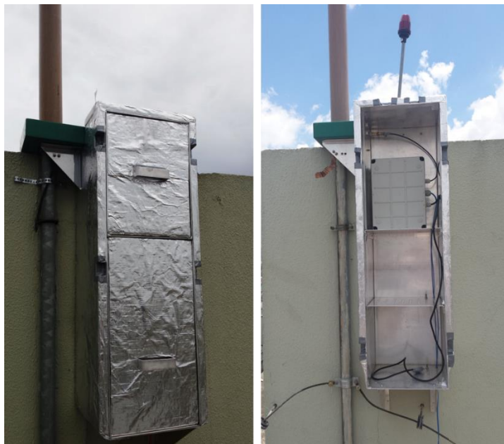
Figura 3.16 – Suporte utilizado para armazenar os equipamentos responsáveis pela transmissão de dados de corrente.
