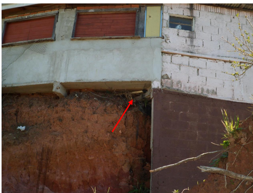
Figura 2.9. Exemplo de construção com encanamento à vista.
