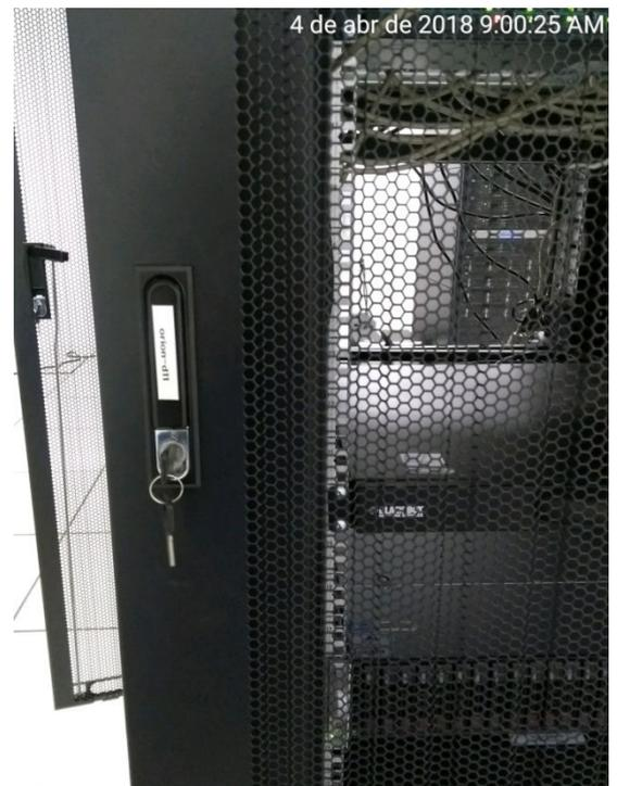
Fig. 04 – No orion-d11, placa de patrimônio, nós computacionais, switch (FAPESP), unidade de armazenamento e a porta da unidade.
