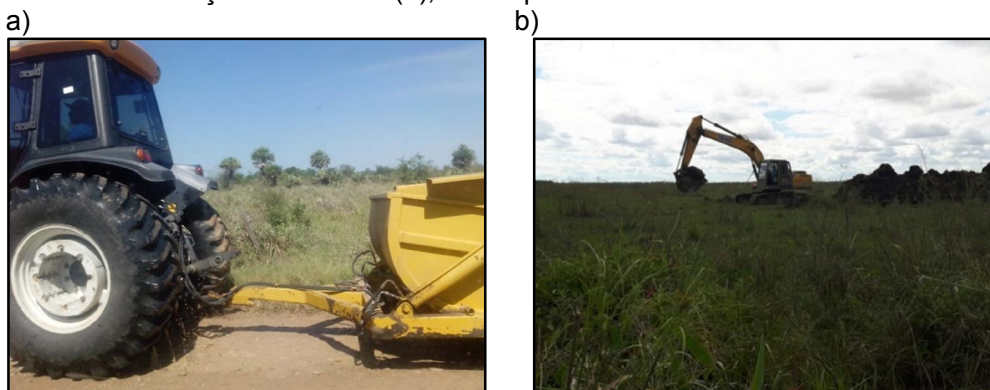
Figura 2.18 - Transporte de suprimentos por trator (a) e construção de aterro para criação de estrada (b), município de Corumbá.
