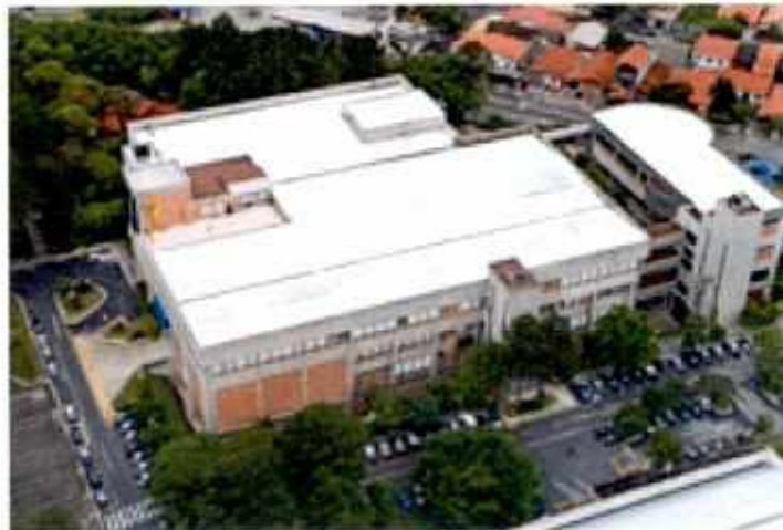
Figura 2 – Prédio do LIT
