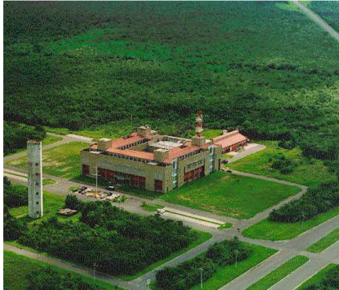
Figura C.3 - Vista do Centro Técnico (CT).
