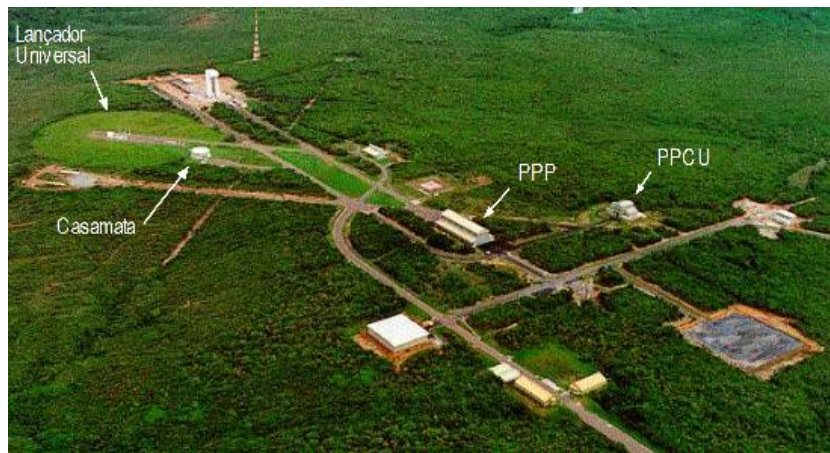
Figura C.4 - Vista aérea do Setor de Lançamento do Centro de Lançamento de Alcântara (CLA).
