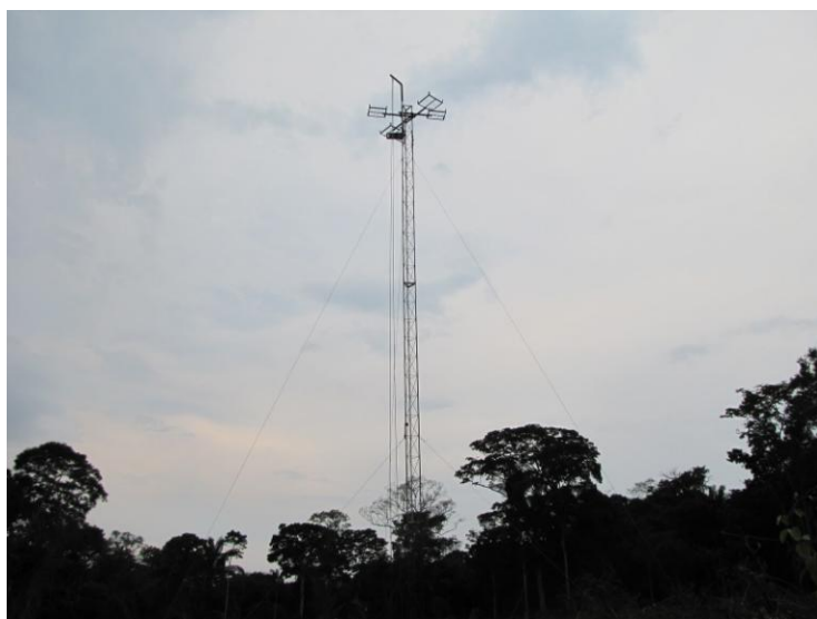
Figura 5 - Torre de coleta de gases montada na área de queima.
