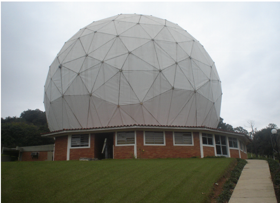
Figura 3.1.1 – Rádio-Observatório do Itapetinga
